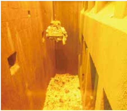
長寿命化の工事が計画されている焼却施設
