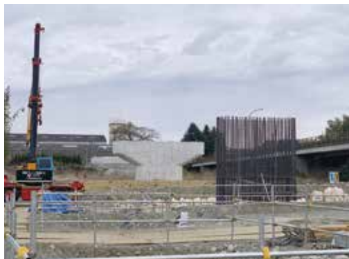
建設途中の新内貴橋橋脚
