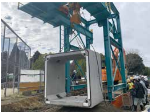
ボックスカルバートが埋設される様子
