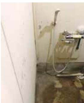
浴室はあるが浴槽がない住宅
