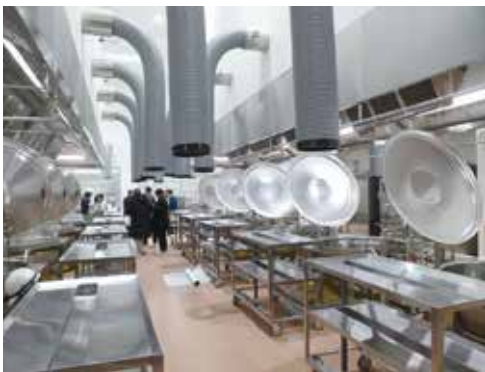
西部学校給食センターの内部
