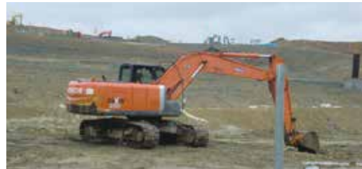
産業振興基盤の拡充（雇用促進）を目指し、着々と工事が進む「甲賀北工業団地」
